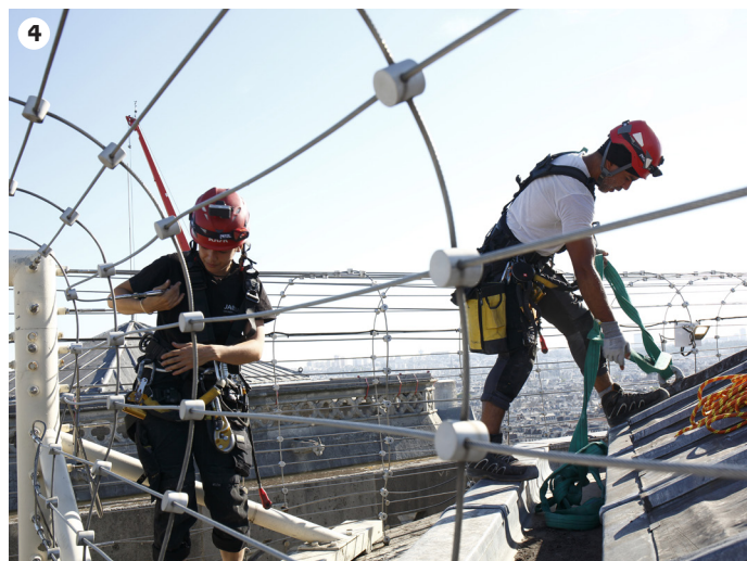
1 Cordiste au cours du démontage de l'échafaudage sinistré
