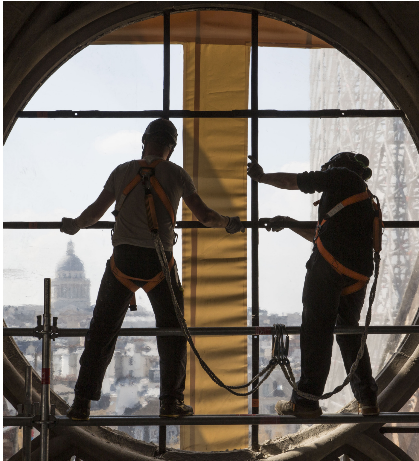
Cordistes démontant l'échafaudage sinistré © Patrick Zachmann – Magnum Photos
