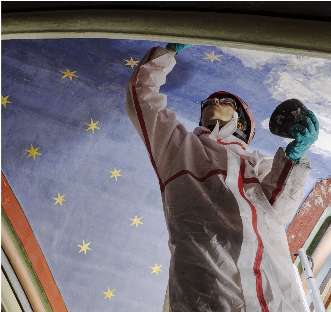
Restauratrice de peintures sur le chantier-test des chapelles © Patrick Zachmann – Magnum Photos
