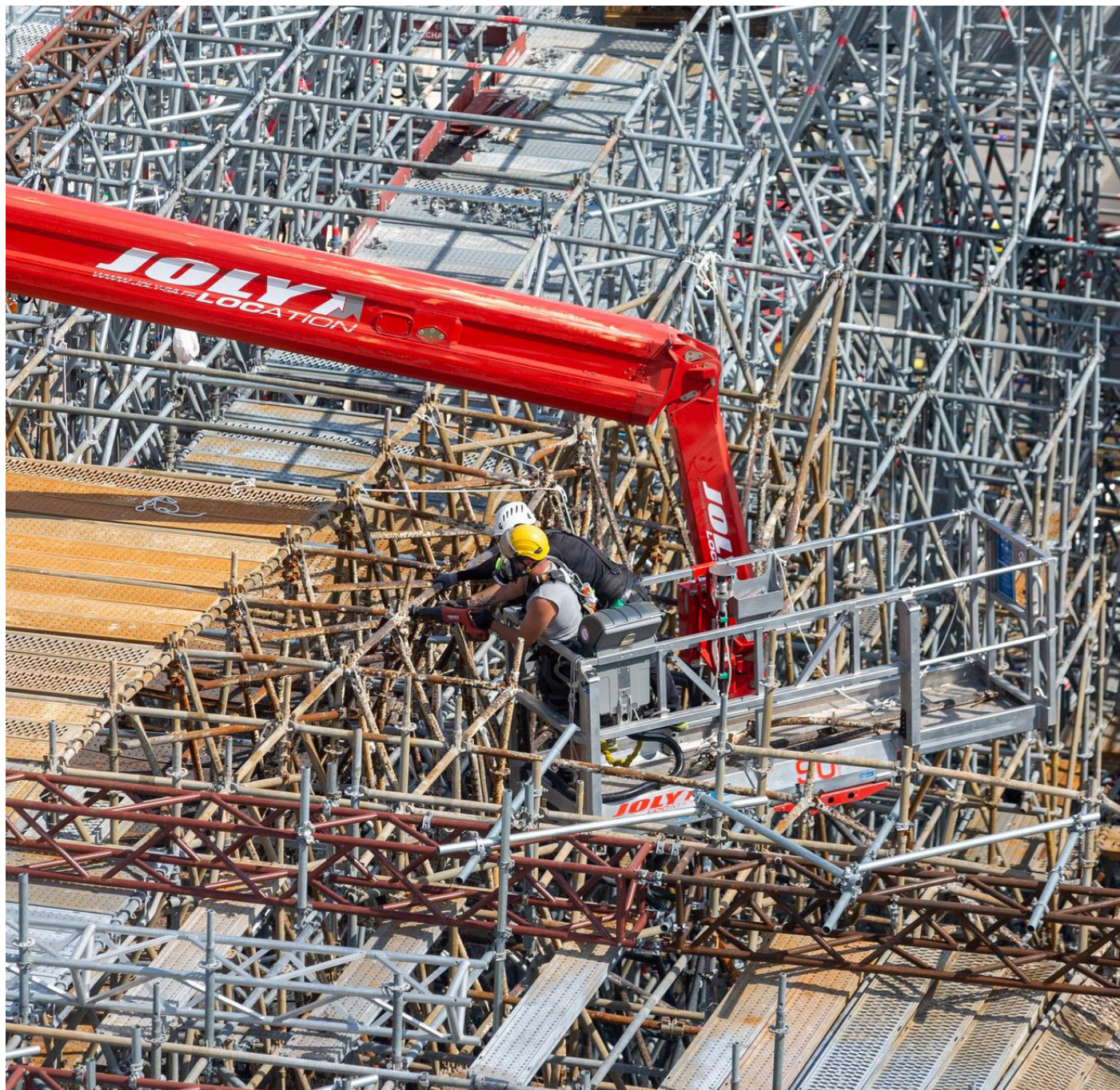
Démontage de l'échafaudage sinistré © Patrick Zachmann – Magnum Photos
