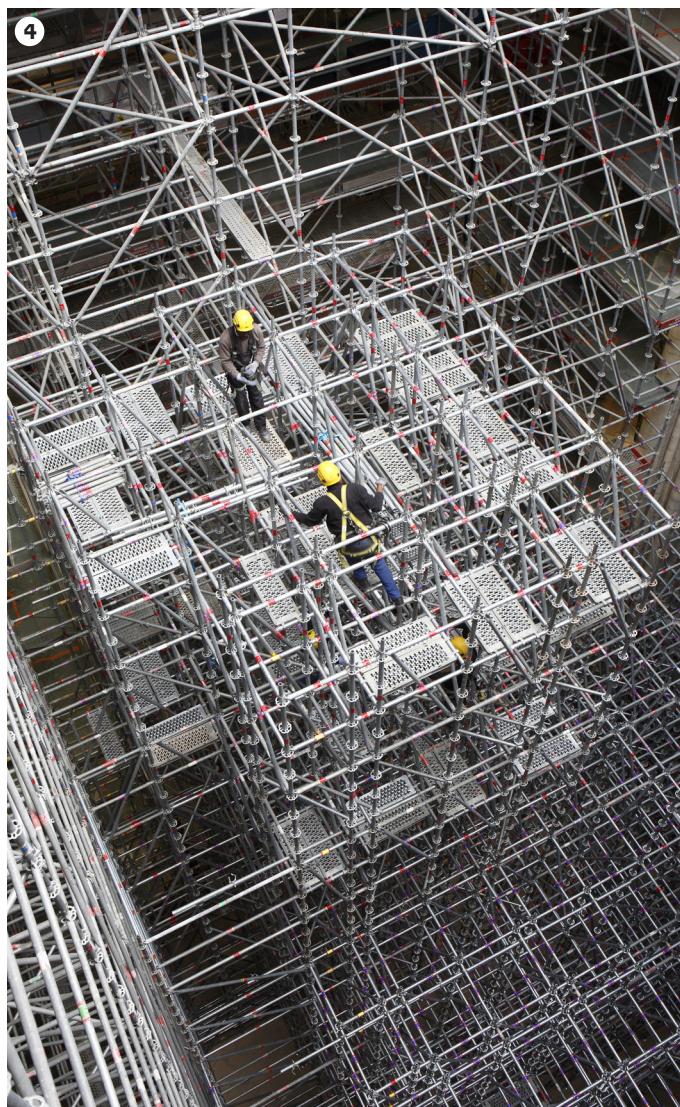
3/4 Montage des échafaudages à l'intérieur de la cathédrale © Patrick Zachmann – Magnum Photos
