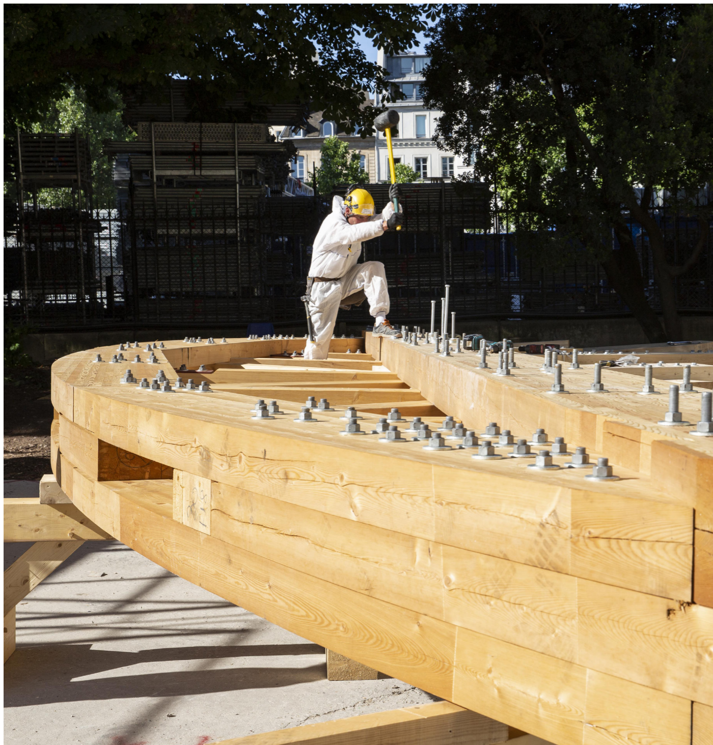
Charpentier sur le chantier de Notre-Dame de Paris © Patrick Zachmann – Magnum Photos
