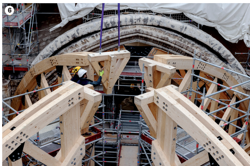
4 Un charpentier achemine un cintre sous les voûtes depuis une plateforme extérieure © Patrick Zachmann – Magnum Photos
