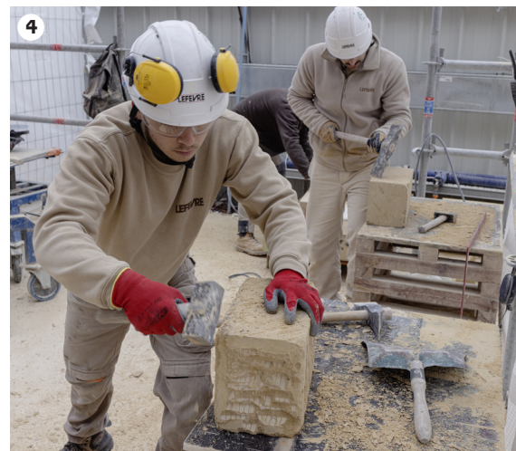
1 Des maçons-tailleurs de pierre sécurisent les éléments de maçonnerie © David Bordes – EPRNDP
