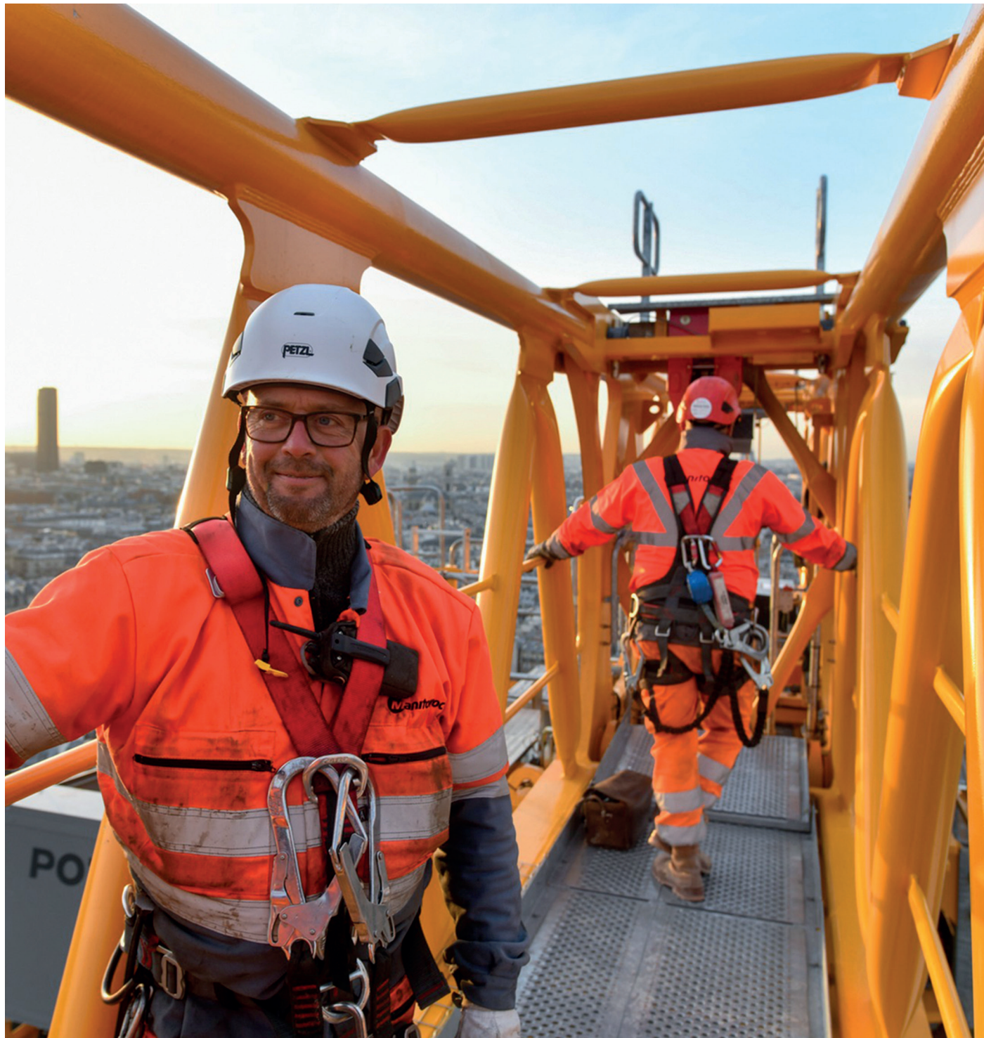
Grutiers sur le chantier de Notre-Dame de Paris © Franck Badaire
