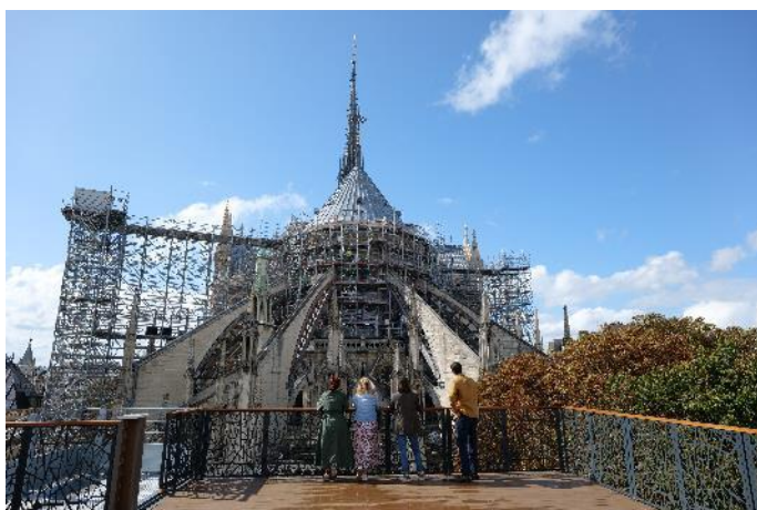
Visuel 5 – La terrasse panoramique située au 5e étage de la base-vie sera exceptionnellement accessible au public, réservant aux visiteurs du Village du chantier une vue unique sur le chevet de la cathédrale. Romaric Toussaint © Rebâtir Notre-Dame de Paris
