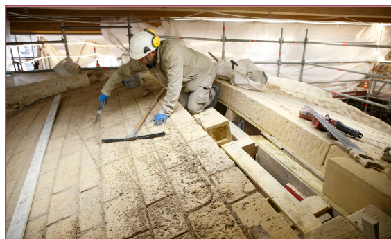
Reconstruction d'un voultain dans le bras nord du transept David Bordes © Rebâtir Notre-Dame de Paris
