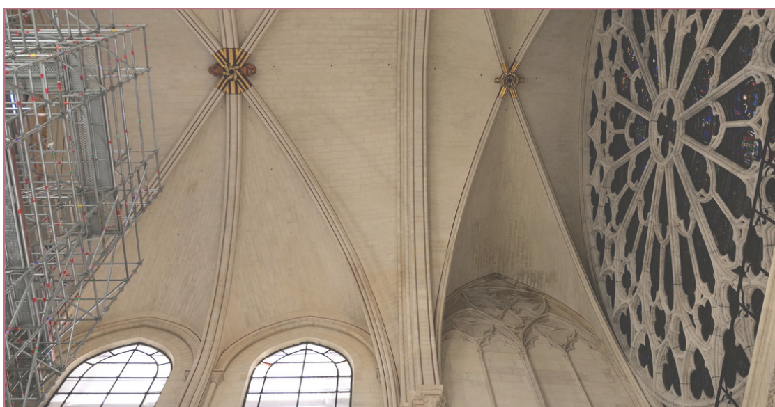
La vue dégagée des voûtes du bras sud du transept, une fois les échafaudages démontés Davis Bordes © Rebâtir Notre-Dame de Paris
