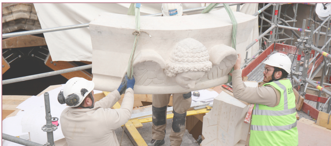
Copie de l'ange, réalisés par les sculpteurs, ornant l'oculus zénithal en cours d'installation. Davis Bordes © Rebâtir Notre-Dame de Paris
