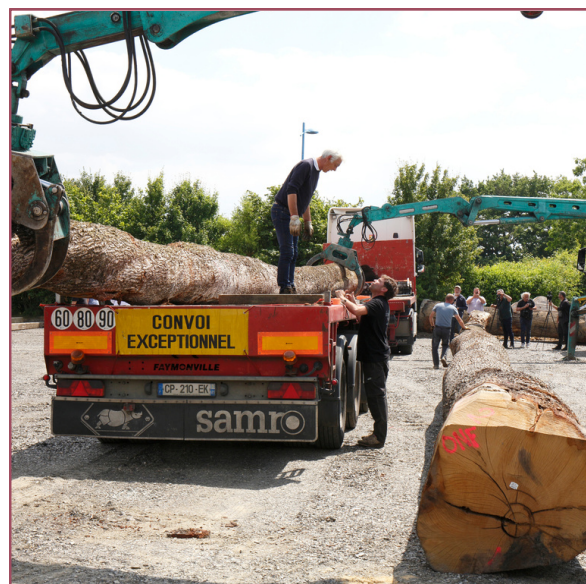
Récolte et transport jusqu'en atelier des bois nécessaires à la reconstruction des charpentes et de la flèche de la cathédrale David Bordes © Rebâtir Notre-Dame de Paris
